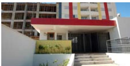
**BLOCO B** – A execução da sétima laje dos pavimentos-tipo foi agendada para o dia 31 de maio, cumprindo-se, assim, a meta de quatro lajes por mês. Foram iniciadas as alvenarias do térreo, do primeiro e do segundo pavimento-tipo. Também já foi executado o reservatório inferior.
